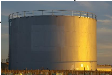
LNG storage tank
